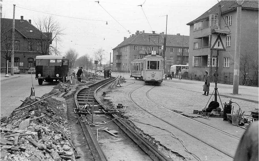
Gleisbauarbeiten auf der Hamburger Straße am 5. April am Roten Kreuz, die die S-Kurve zum Fahrspurwechsel nur entschärfen, aber noch nicht beseitigen. Rechts ein Anschlußbus der Linie 14 nach Veltenhof. In der Mitte Tw112 mit Bw285, links steht der Bau-LKW vor der Gaststätte „Altes Forsthaus“, das etwa sechs Jahre später abgerissen wurde. An dieser Fotostelle liegen heute die Haltestelleninseln „Gesundheitsamt“.
