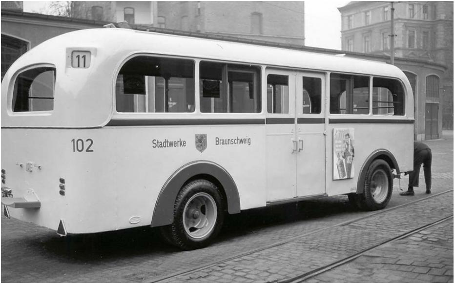
Omnibusanhänger 102, Waggonfabrik Wismar 1942. Nach seiner Hauptuntersuchung am 12. Oktober 1953 auf dem Betriebshof Altewiek. Die Vorderachse wurde von Einzelradlenkung auf Anlenkung der gesamten Achse um einen mittleren Drehpunkt umgebaut. Daher mußten vorn die Schürzen gekürzt werden.
