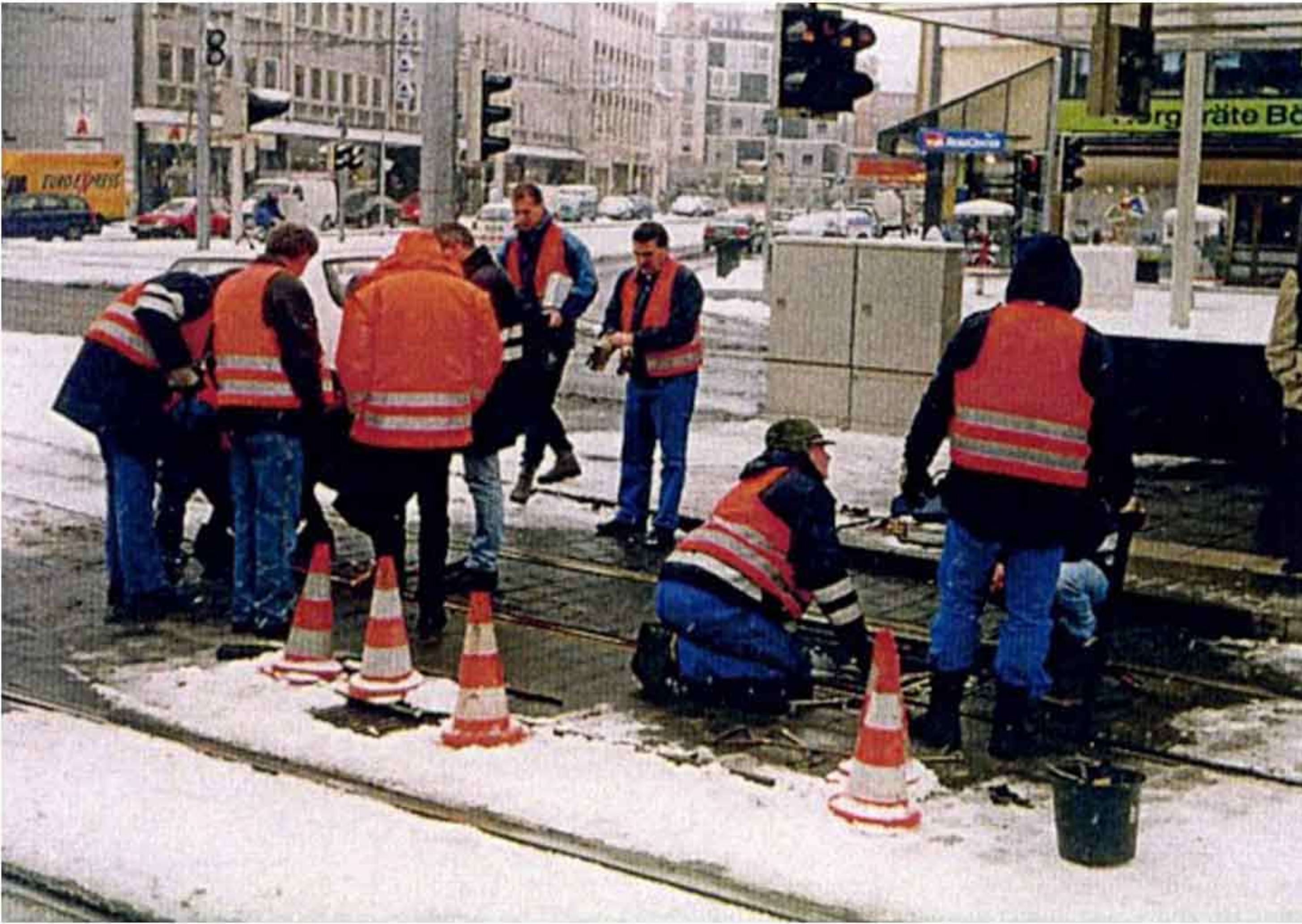
Eine Weichenzunge wurde repariert.
